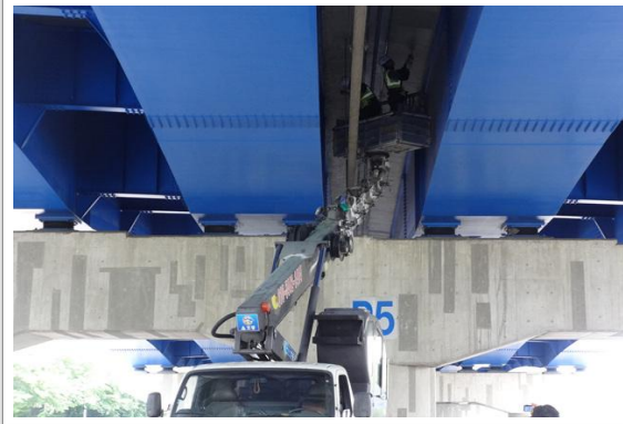
고소차점검차를 이용한 점검
