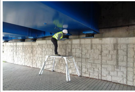
점검사다리를 이용한 점검
